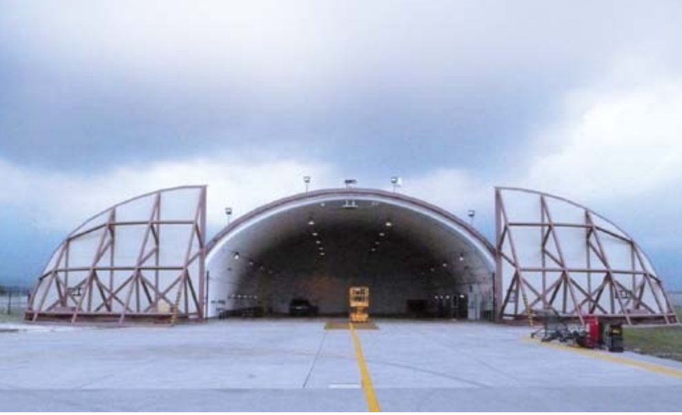
Verbindung zum Hangar via Glasfaserkabel
